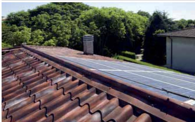
ISOPAN SAFE STRUCTURAL è un sistema di fissaggio in colmo a base piana realizzabile in presenza di travi in legno, ferro e calcestruzzo.
