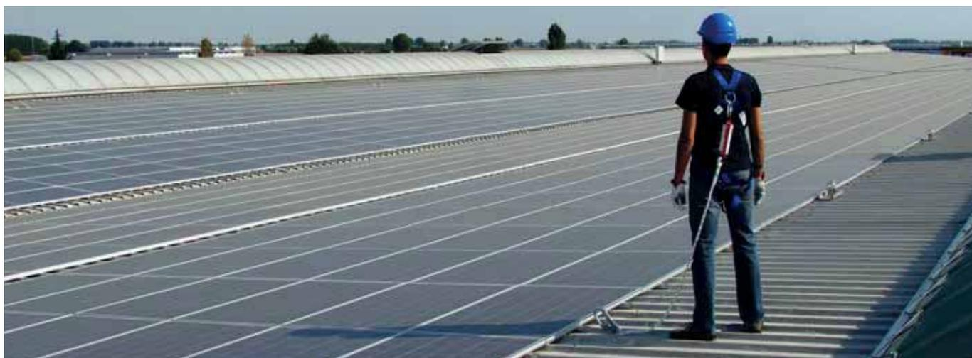
ISOPANSAFE nasce per garantire la sicurezza dei lavoratori in quota sulle coperture e per consentire loro piena libertà di movimento in fase di intervento; i dispositivi realizzati sono marcati CE e certificati secondo la norma UNI EN 795 2002.
