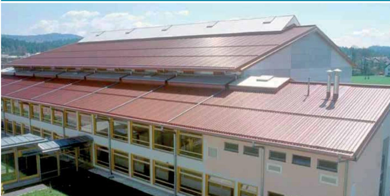
Pannello sandwich monolamiera, dalle limitate prestazioni estetiche, per coperture con pendenza non inferiore a 7%. Coibentato in poliuretano, con lamiera esterna profilata a 5 greche. Il fissaggio è di tipo a vista, con apposito cappello con guarnizione. Il supporto interno è costituito da alluminio centesimale goffrato.
