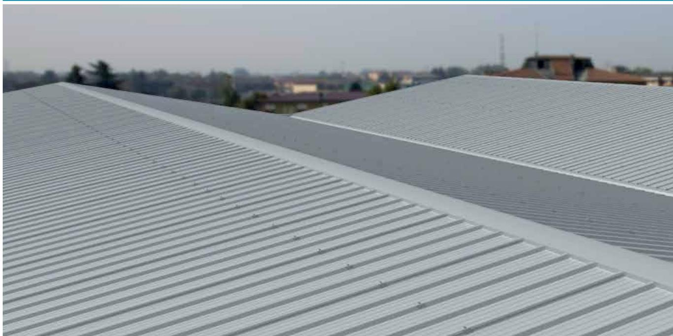
Pannello sandwich a doppio rivestimento metallico, per coperture con pendenza non inferiore a 7%, coibentato in poliuretano, con lamiera esterna profilata a 5 greche. Il fissaggio è a vista, con apposito cappellotto con guarnizione.
