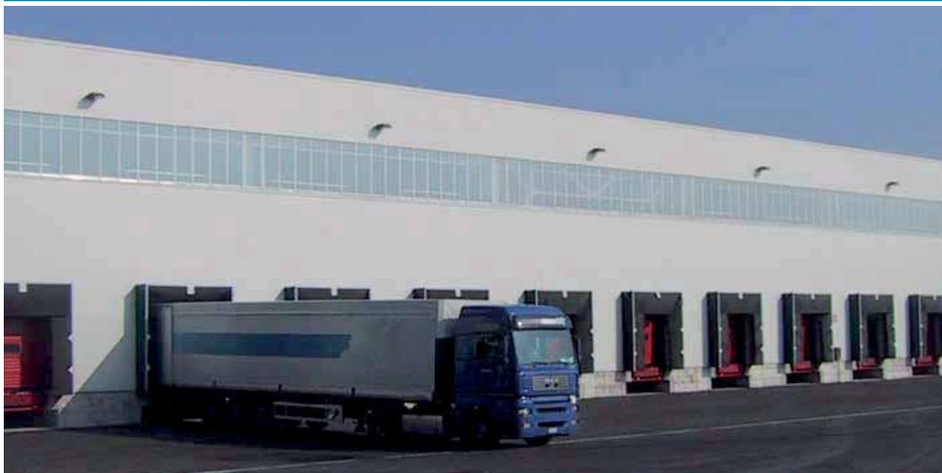
Pannello da parete a doppio rivestimento metallico con isolamento in lana minerale. Il giunto, con incastri maschio-femmina, è di tipo a vista, con vite passante.
