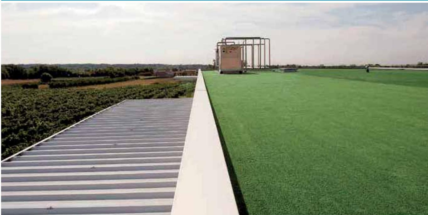
Pannello sandwich monolamiera, per coperture con pendenza non inferiore a 7%, coibentato in poliuretano, con lamiera esterna profilata a 5 greche. Può essere utilizzato per la realizzazione di coperture piane, grazie al supporto in cartongfello bitumato.
