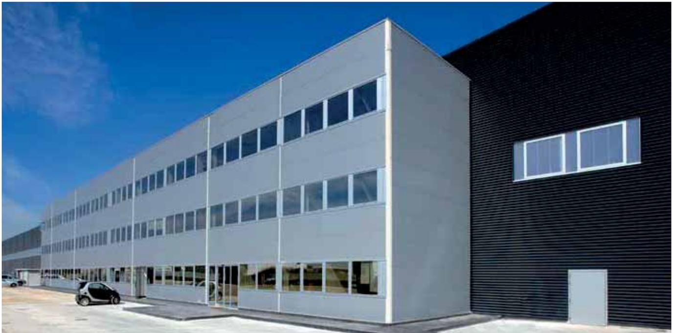
Pannello da parete a doppio rivestimento metallico con isolamento in poliuretano, dal profilo esterno ondulato. Il giunto, con incastrì maschio-femmina, è di tipo nascosto, con viti passante. Disponibile in diversi tipi di profilatura.
