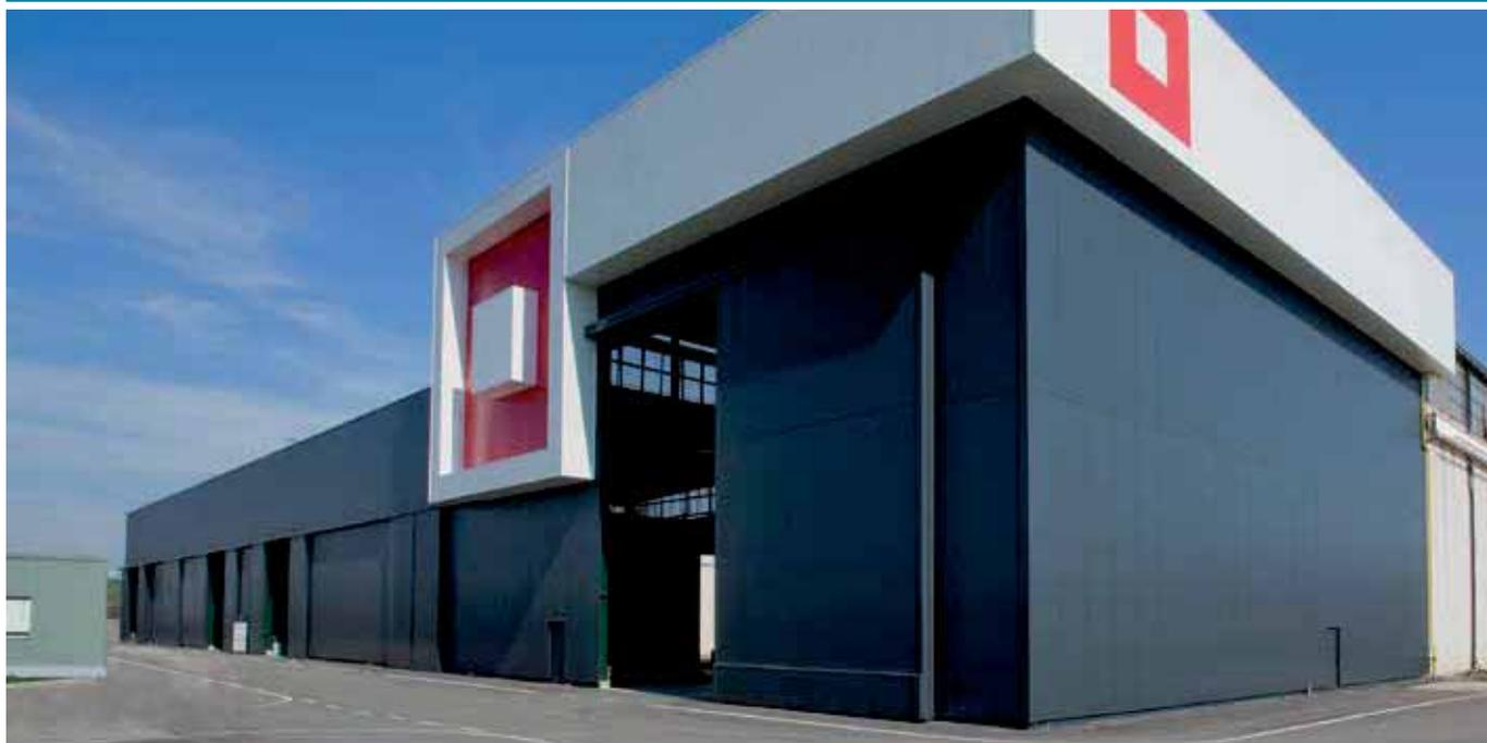
Pannello da parete a doppio rivestimento metallico con isolamento in lana minerale. Il giunto, con incastri maschio-femmina, è di tipo nascosto, con vite passante.
