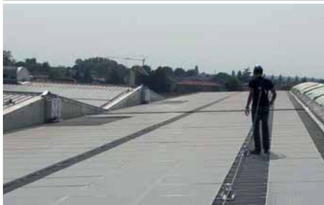
ISOPAN SAFE BASE è un sistema di fissaggio a falda, il cui utilizzo è vincolato alla presenza di coperture realizzate con pannelli ISOCOP-5 1000 o ISODOMUS; sono disponibili 3 tipi di fissaggio, rispettivamente alla sottostruttura, alla sovrastruttura o ibrido.
