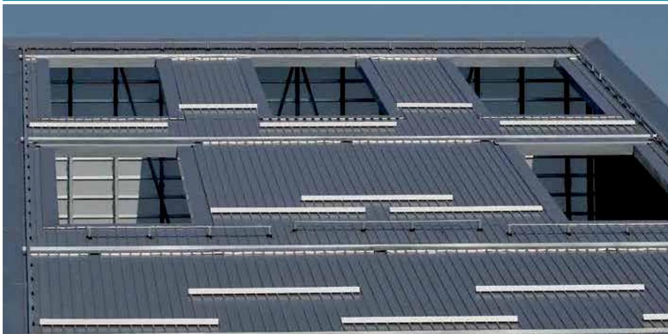
Pannello sandwich a doppio rivestimento metallico, per coperture con pendenza non inferiore a 7%, coibentato in lana minerale, con lamiera esterna profilata a 5 greche. Il fissaggio è di tipo a vista, con appositi cappellotti metallici con guarnizione.
