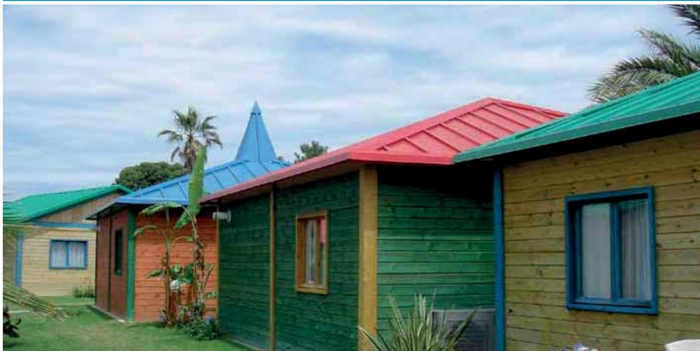
Pannello sandwich a doppio rivestimento metallico, per coperture con pendenza non inferiore a 7%, coibentato in poliuretano, con lamiera esterna profilata a 3 greche. Il fissaggio è di tipo nascosto, con apposito cappello in coprigiunto a incastro.
