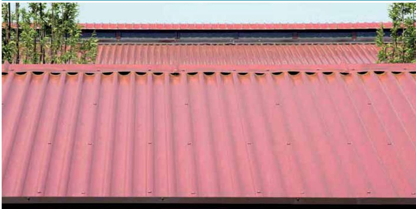
Pannello sandwich a doppio rivestimento metallico, per coperture con pendenza non inferiore a 7%, coibentato in poliuretano, con lamiera esterna profilata a 6 onde. Il fissaggio è di tipo a vista con appositi cappellotti e guarnizioni.
